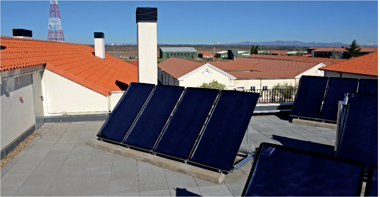
Instalación de paneles fotovoltaicos en el aeródromo militar de León
