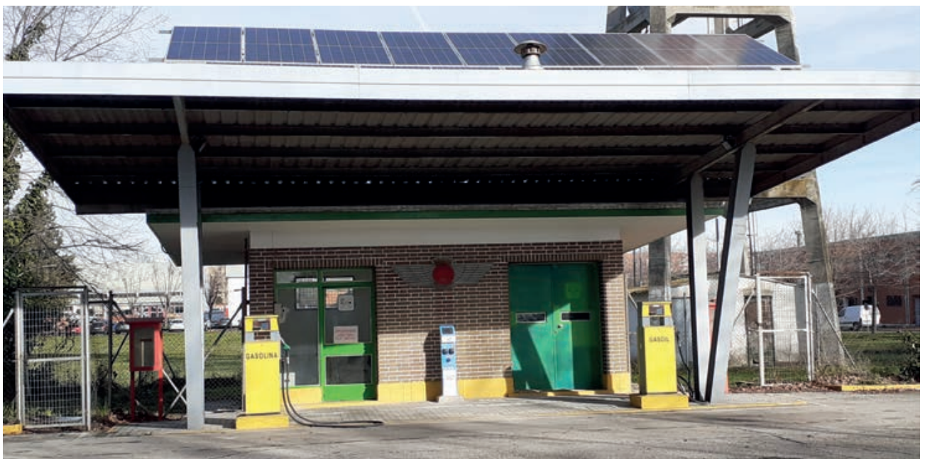
Punto de carga de vehículos eléctricos basado en energía solar en el ACAR de Getafe
