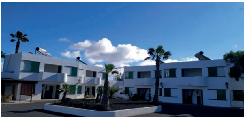
Captadores de energía solar térmica en el aeródromo militar de Lanzarote
